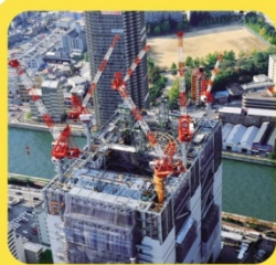
ビルの鉄骨と クレーン
