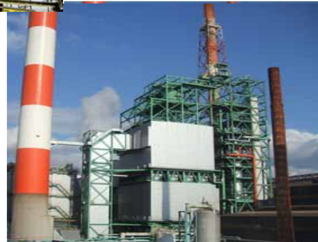
活性コークス式脱硫脱硝設備
