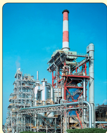
発生する熱やガスを利用した自家発電装置
