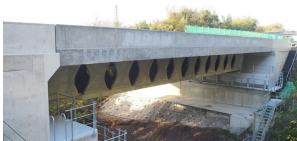
徳島自動車道 別埜谷橋（2020年）
