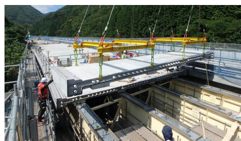
中国自動車道 蓼野第二橋（2021年）
