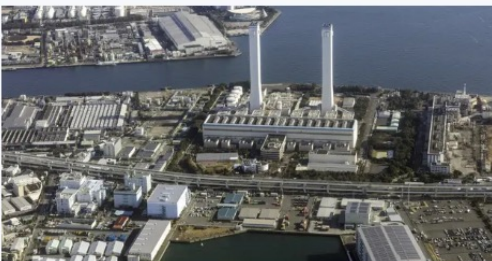
> 発電所・変電所
