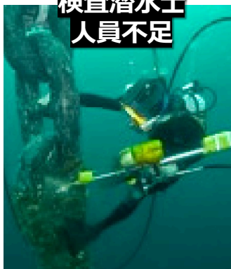
港湾施設 老朽化
