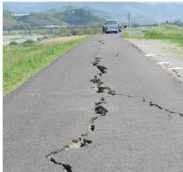
2016年熊本地震における鋼矢板工法で補強した河川堤防の被害要因分析
