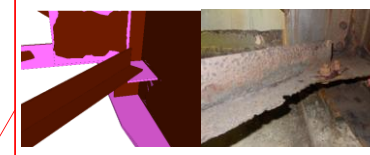
下横構ガセットの腐食
