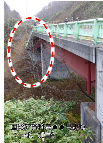
谷筋からの長期にわたる基礎地盤の 浸食によって沈下した橋台
