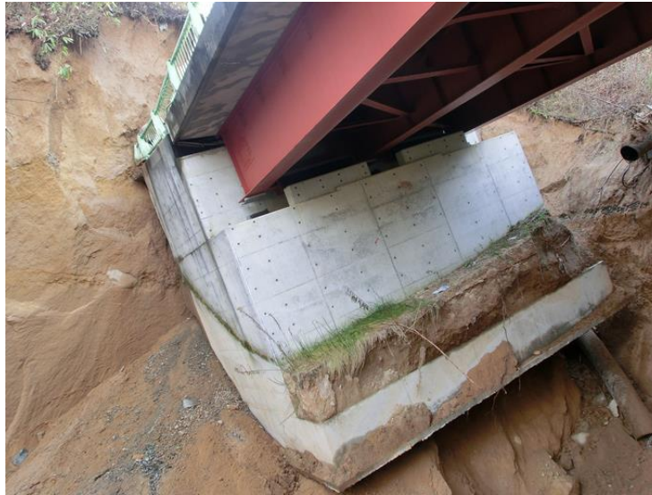
谷筋からの長期にわたる基礎地盤の 浸食によって沈下した橋台
