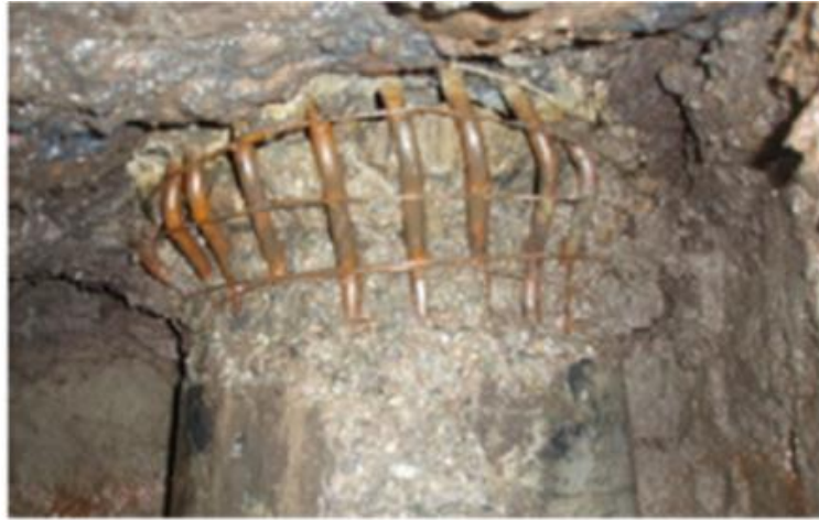
地震時の被害（既製RC杭）
