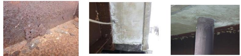
竣工後15年経過。A1端部の床版および排水管取付部ボルト孔から漏水(健全度II)により、主桁および横桁に粗いさびが見られる(健全性II)
