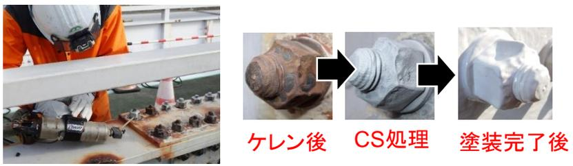
施工精度、施工角度等はクリア、小規模橋梁のボルト部と相性○
