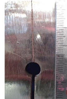
SHからのき裂
