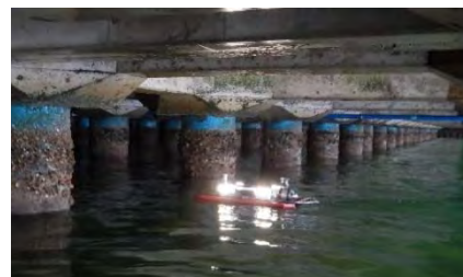
ROVによる撮影状況
