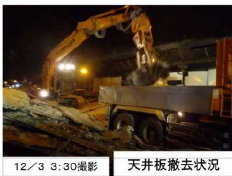
笹子トンネル天井板落下事故(2012年12月) 国土交通省近畿地方整備局
