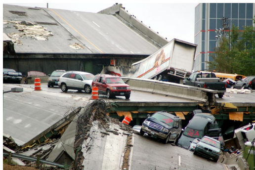
米国・ミネアポリス高速道路崩落事故 (2007年8月) Rofidal, K. (2007)
