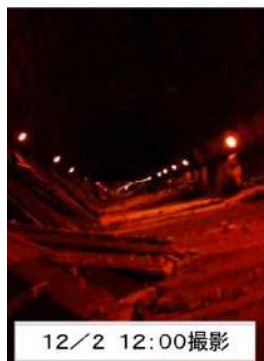
笹子トンネル天井板落下事故(2012年12月) 国土交通省近畿地方整備局
