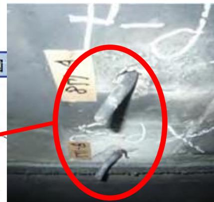
樹脂アンカーで固定された天井板が落下
