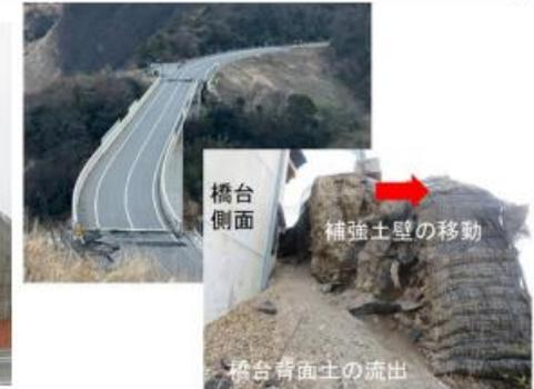
復旧にあたり、撤去に時間がかかる補強土壁の損傷事例
