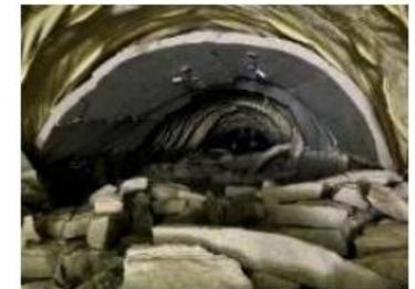
覆工コンクリート崩落(大谷トンネル)
