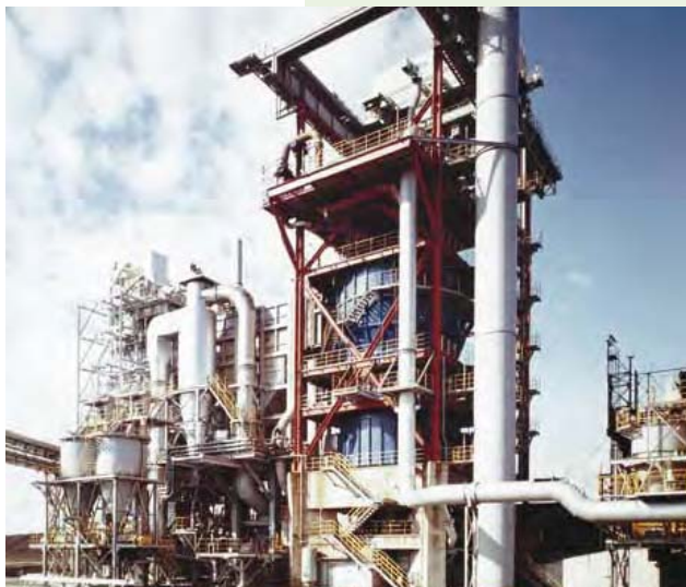
CDQ (コークス乾式消火設備)
