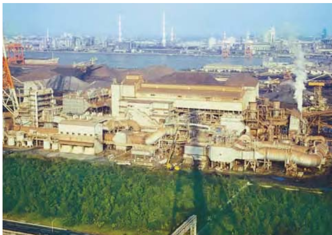
焼結機排煙の脱硫脱硝設備
