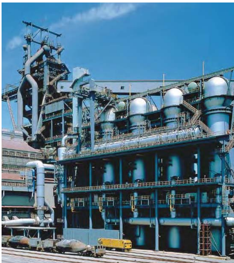
高炉 空高くそびえる高炉は、鉄鋼一貫製鉄所のシンボル。上部から原料を装入し、下部から約1,200℃の熱風を吹き込み、鉄鉱石を還元・溶解させ、鉄鉄をつくる。
