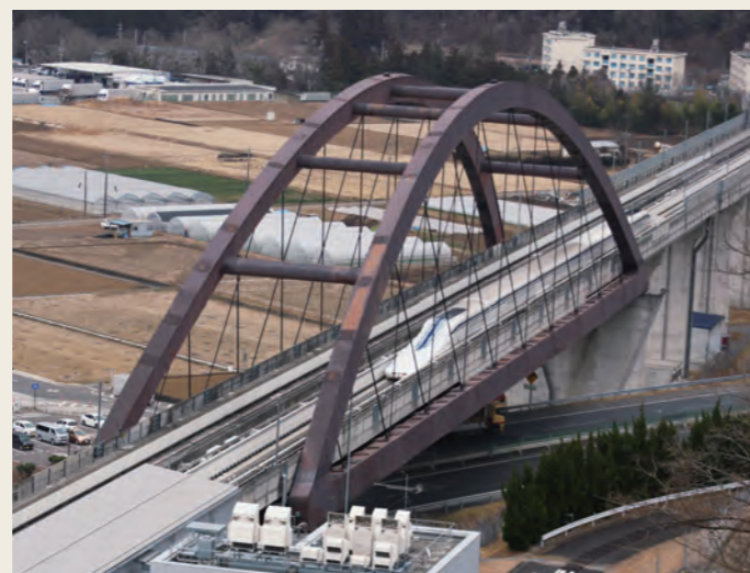
耐候性鋼用表面処理の適用事例
