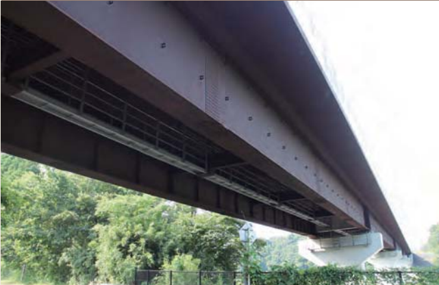
千葉県 芝第2高架橋 (2主I桁+合成床版)
