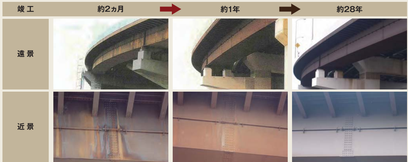
阪神高速4号湾岸線 三宝入路橋
