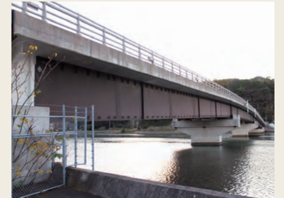
長崎県 瀬戸中央橋
