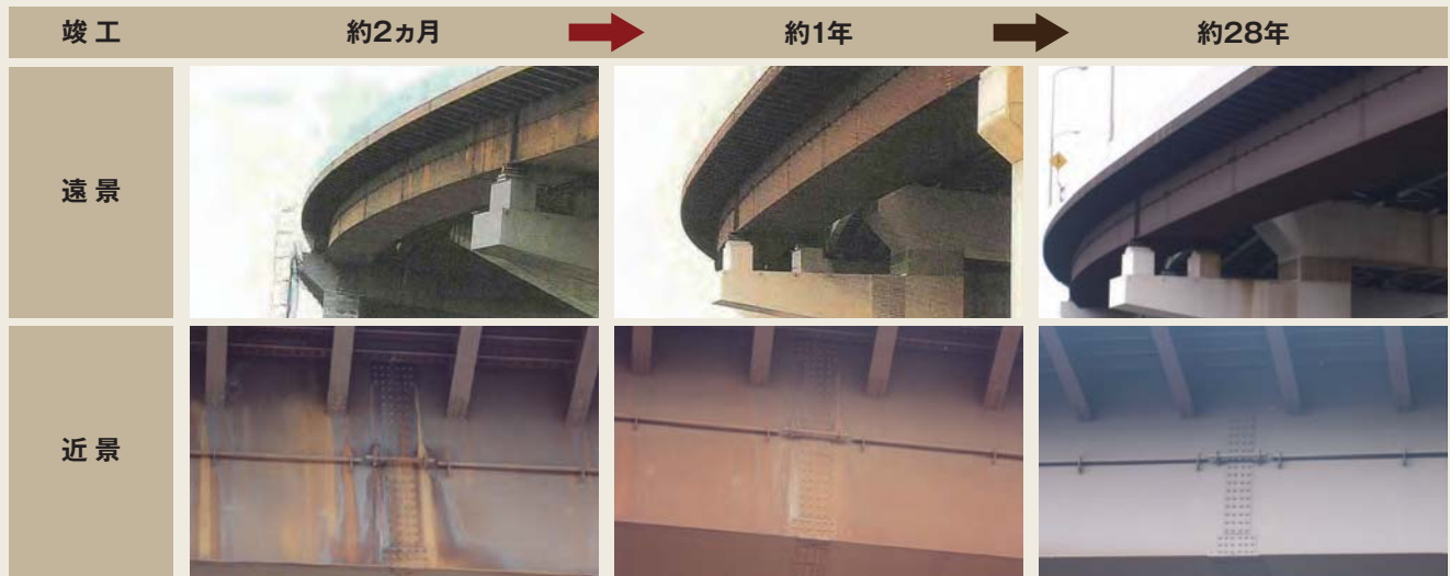
阪神高速4号湾岸線 三宝入路橋
