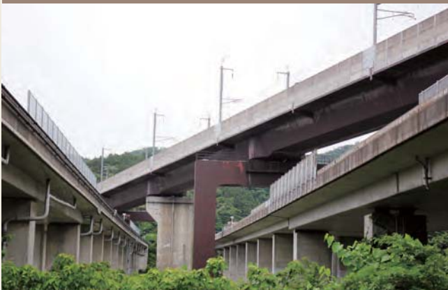
新潟県 北陸道架道橋 (ニッケル系高耐候性鋼)
