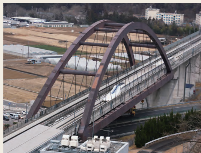
山梨県 小形山架道橋(山梨リニア実験線)
