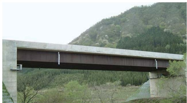
桁端部を橋台と一体化し、雨水等の桁端浸入を防いでいる。
