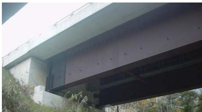
伸縮継手を後方に移動し、桁端への漏水を防いでいる。
