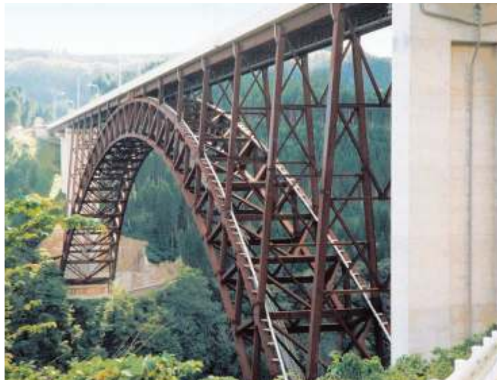
耐候性鋼の裸使用適用例(奥阿蘇大橋)
