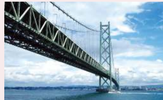
明石海峡大橋
