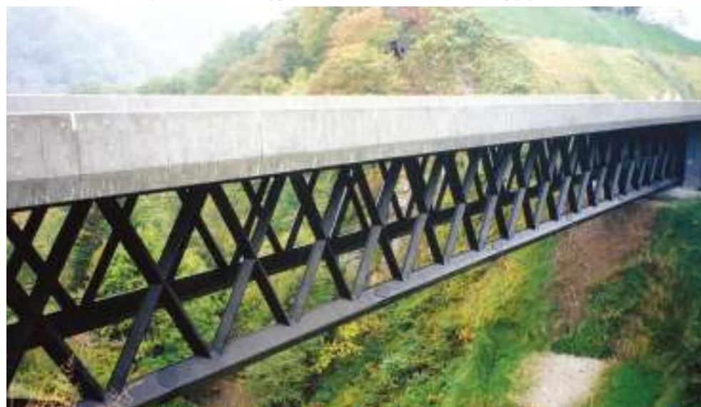
曲げ加工部を有する角型鋼管のトラス橋への適用例(北海道 滝下橋)
