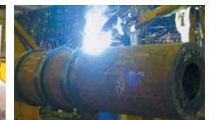
■ ダイアフラム部の溶接
