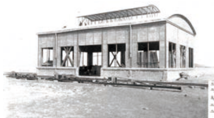
建設中の旧鍛冶工場
