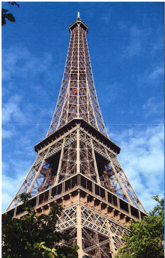
エッフェル塔(1889):約7000t(錬鉄製)
