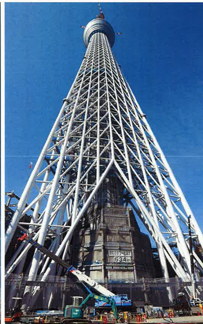
東京スカイツリー(2012): 約36000t(高張力鋼製)
