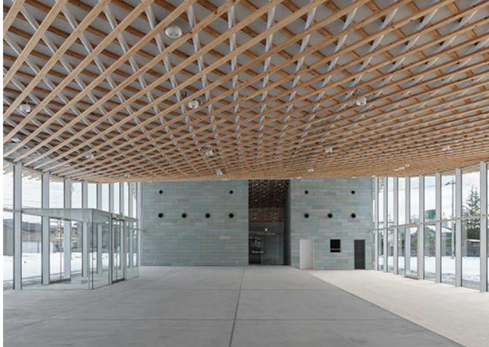
直径100mmの丸鋼に、斜め45度でスギ材を上下に挟んだ天井。部材が編み込まれたように見える
