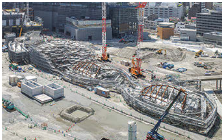
総足場を組み、鉄骨の現場溶接によるジョイントで構造体を組み上げていった
