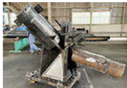
大屋根広場着地部の柱脚
