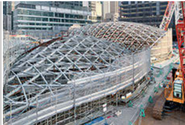
施工中の大屋根。たくさんの細かな材で構成されている
