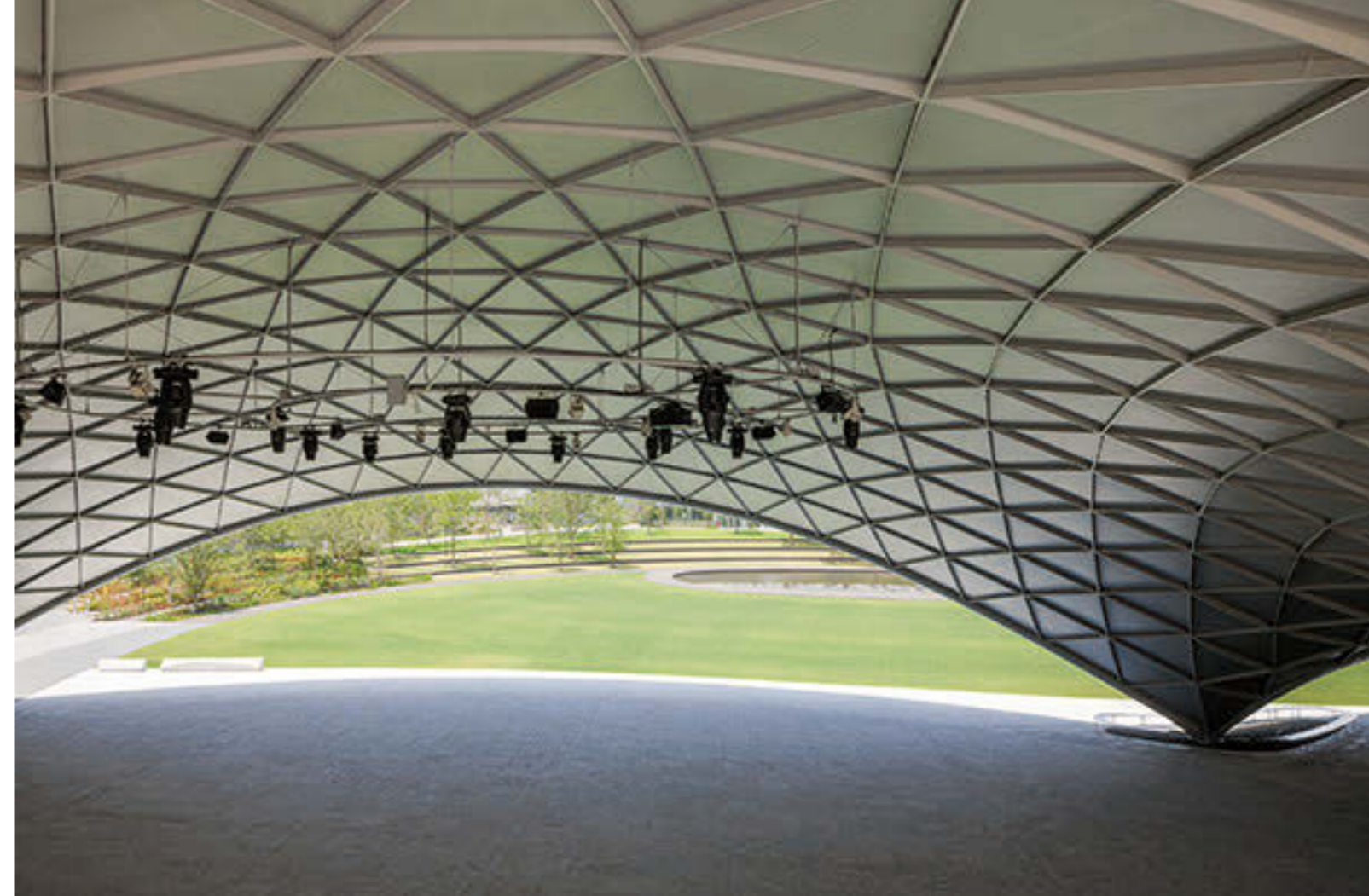
大屋根広場越しに芝生広場を見る。三角形グリッドシェル構造で柱のない大空間を実現している
