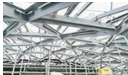
曲線状に切り出されたフラットバーと直状のカットTにより自由曲面を構成している
