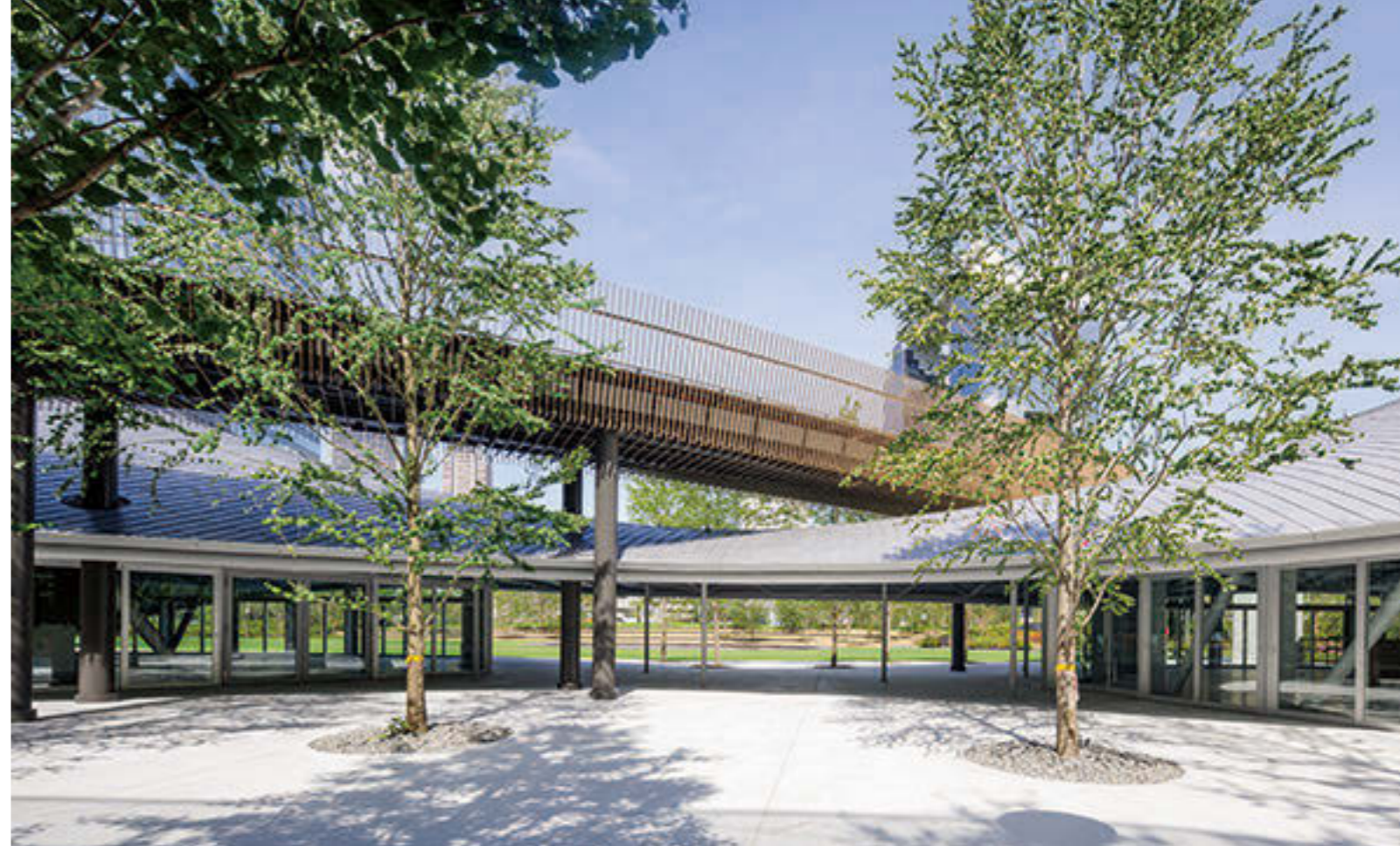
「ひらめきの道」と名付けられた南北の公園をつなぐ歩行者用デッキが屋根と交差する。デッキの柱は屋根を貫通している
