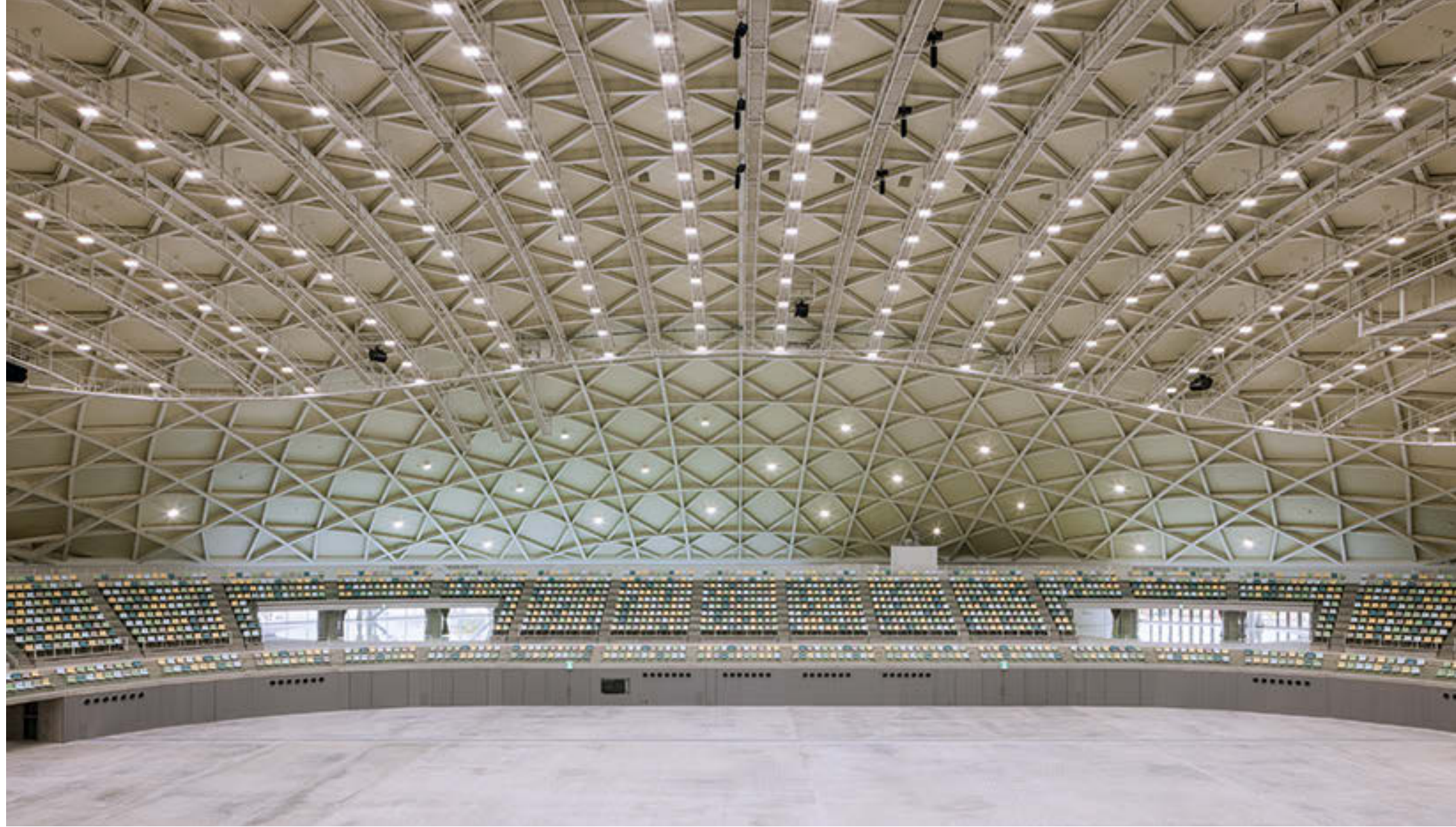
メインアリーナ。直径100mを越すH形鋼による単層ラチスドーム
