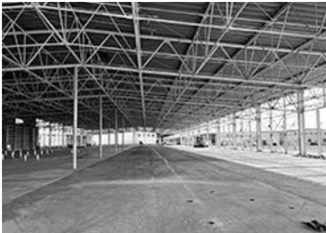
施工風景 外壁を取り外して下部には新たにサッシを設置
