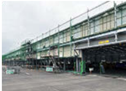
ダブルスキンの外壁を施工中
