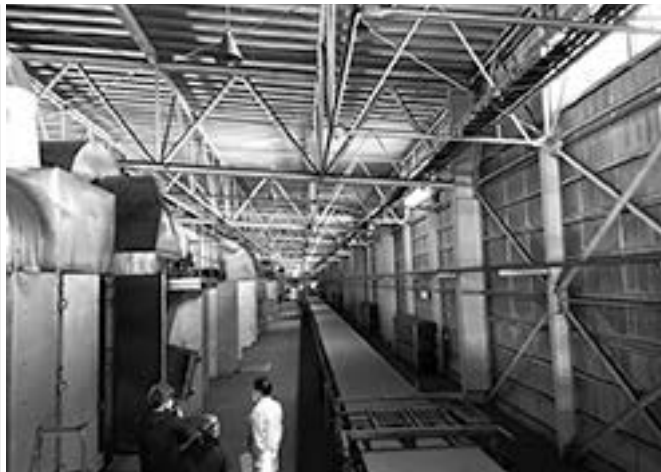
既存建物内部 1996年に建てられ工場として使われていた
