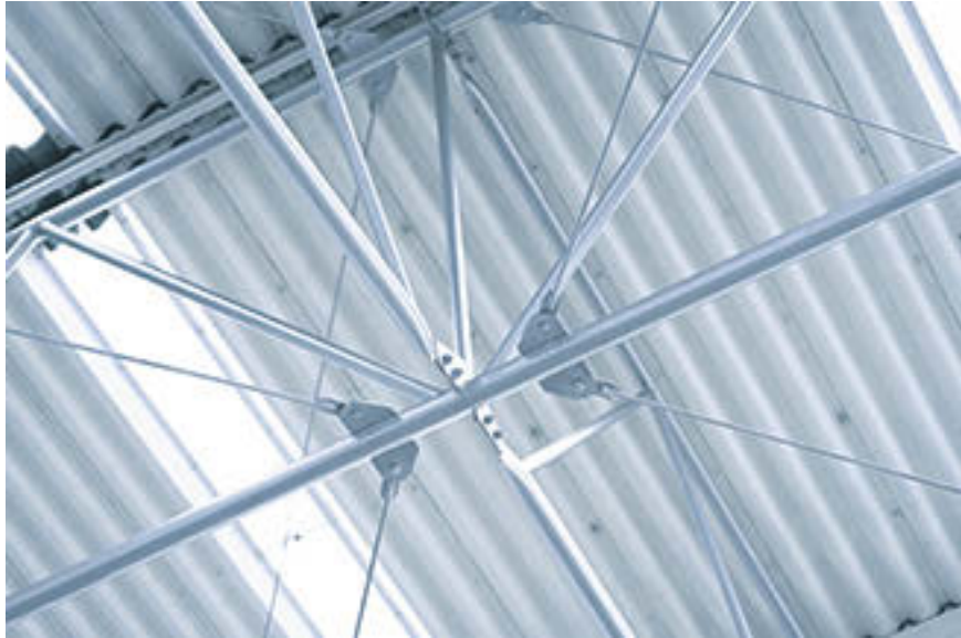
細い材料で構成された既存架構。天井には3.6m間隔でトップライトを設置
