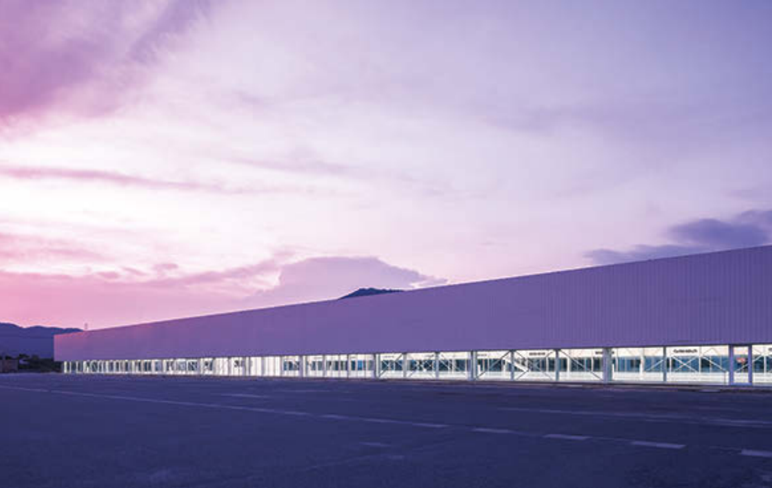
南面の夕景 外壁下部には高さ2,500mmの開口部が4面をまわる
