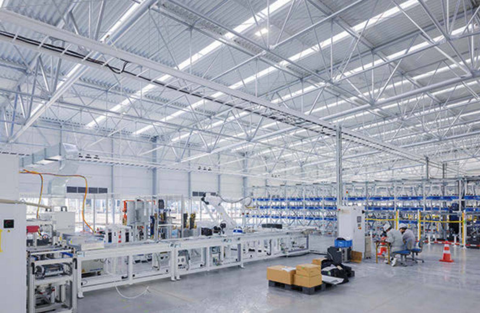
蓄電池生産設備が設置された工場内部。床はコンクリートを打ち直し、フラットに仕上げた
