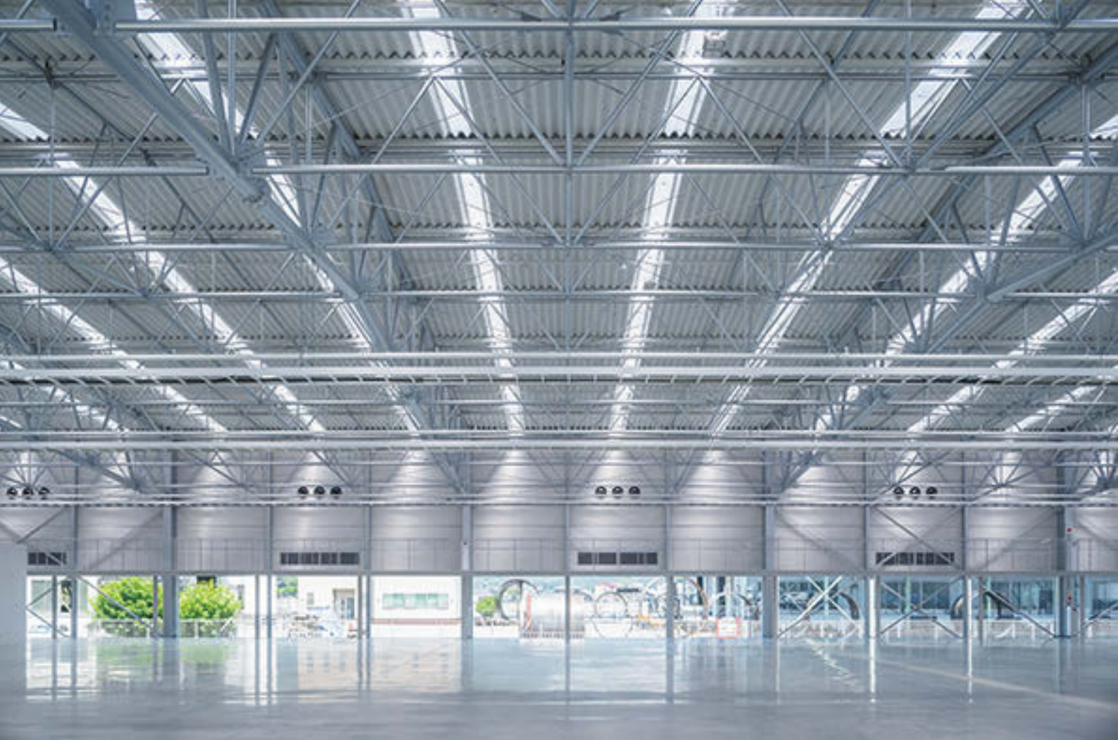
工場内部、北側を見る。既存の鉄骨トラスをシルバーに塗装、壁側高さ2,300mmの位置には見学者通路を新設
