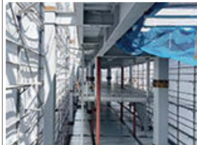
建て方 壁が立つ前の状態。仮の柱を建てながら組み上げる
