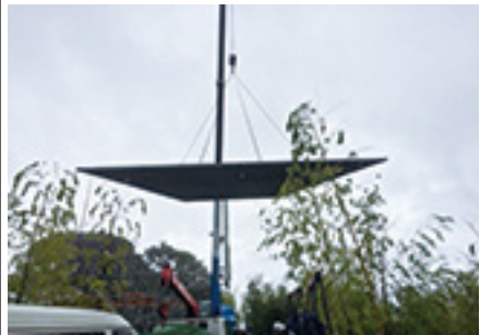
屋根建て方 屋根パネル吊り込み
