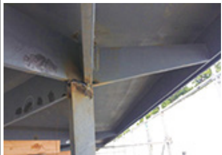
V字柱を菱目梁に溶接
