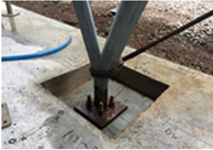
V字柱脚部
