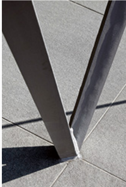
V字柱の脚部
