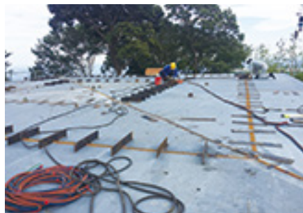
屋根鉄板溶接
