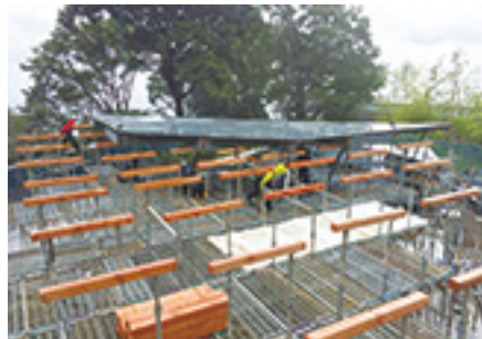
屋根パネルを設置
