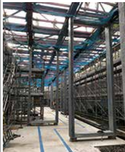
ロの字形フレームの上には井桁状の鉄骨梁が載る
