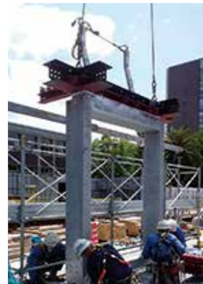
ロの字形鉄骨フレーム、建て方
