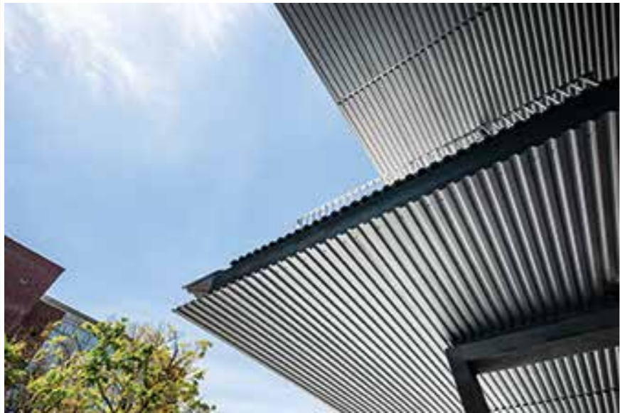
キーストンプレート (ガルバリウム銅板) を使用した天井・庇
