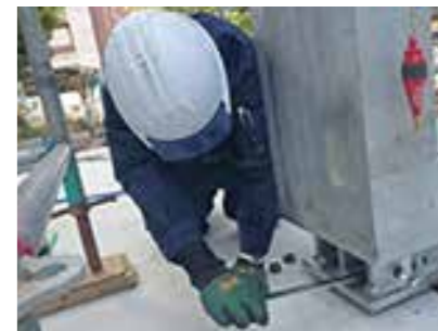
アンカーボルト本締め
