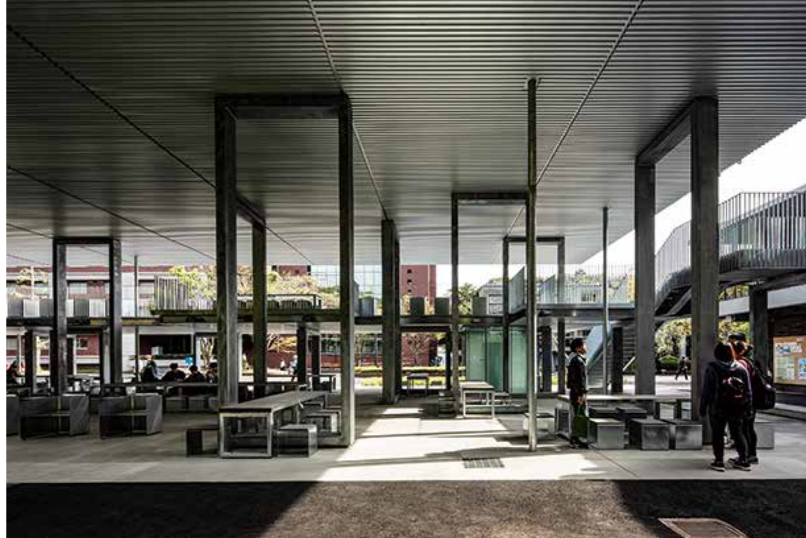
口の字形鉄骨フレームをXY方向に配置
