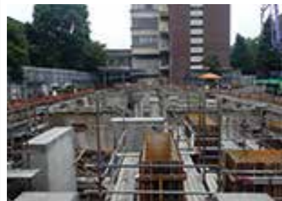
既設基礎の補強工事と基礎新設工事
