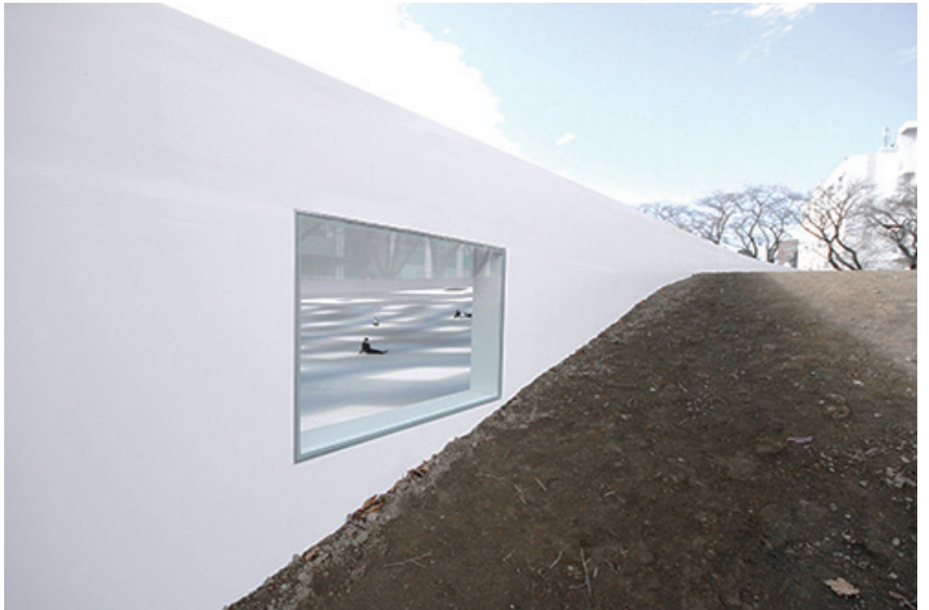
横の窓から内部を見る トップライトと窓から光が差し、内部は全体的に明るい
