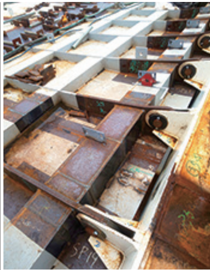
屋根と壁ユニットの接合部
