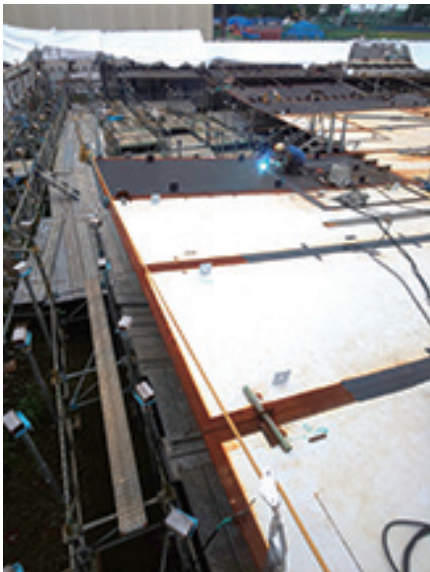
鋼板を現場で溶接する
