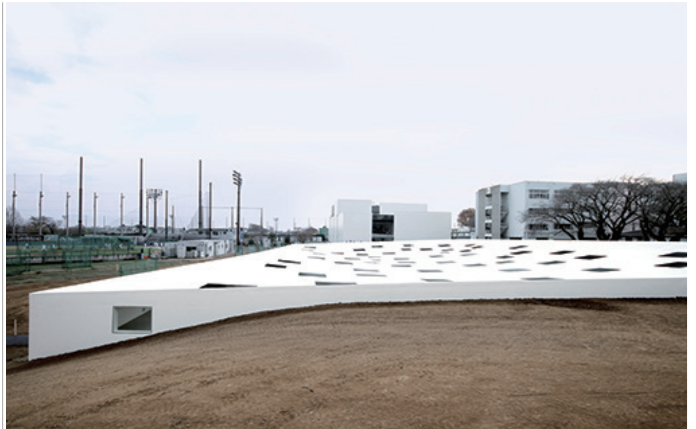
北側から見る ポリュームを抑えた地形と一体化した建物全体に屋根が垂れ下がっている
