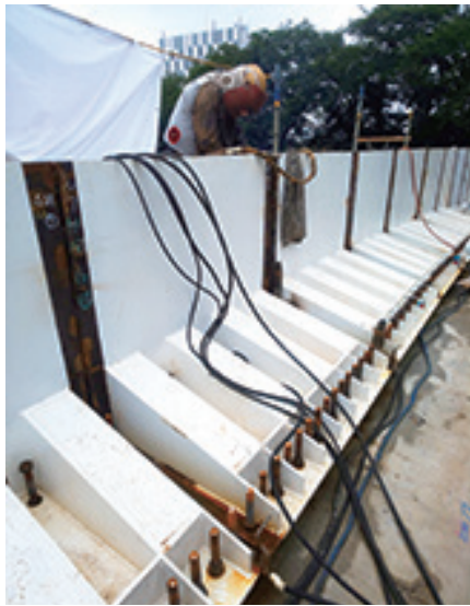
壁ユニットをセッティング 足もとにはアンカーボルトが並ぶ
