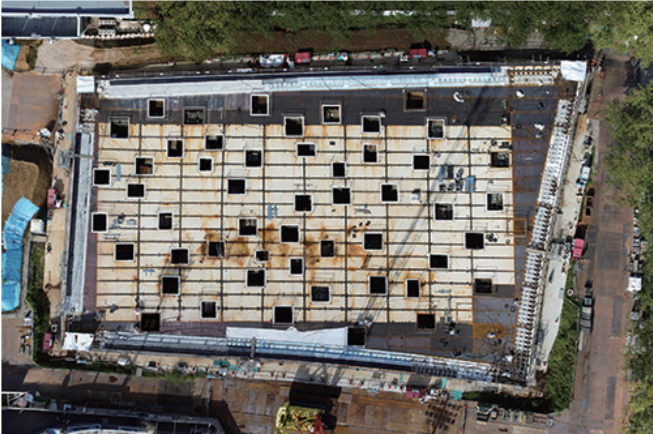
施工中の俯瞰 鋼板屋根には59個の開口が開けられ、外周部には座屈を補剛する3m幅のリブが入っている
