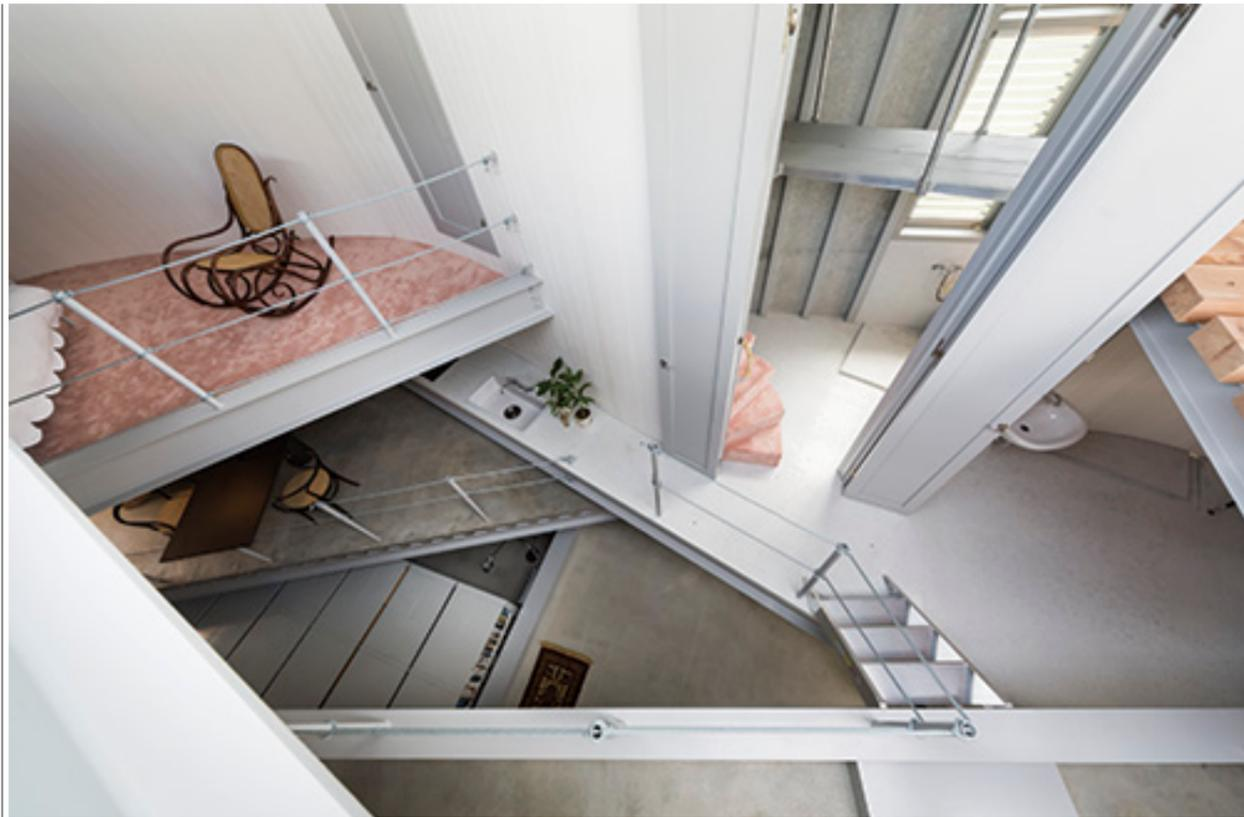
F9フロアから下の階を見る 楕円平面の大きな吹き抜けにさまざまな角度からH形鋼梁が架けられ、形の異なる床をつくり出している
