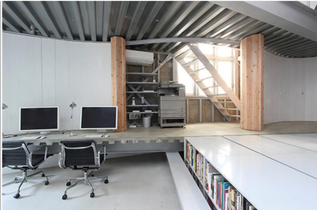
スギ板の巻戸を開くと内装と外装の空間が現れ、柱や窓が見える。デスクになっているスラブは座った時に膝がH形鋼に当たらないように跳ね出している
