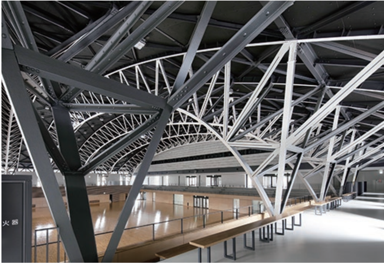
2階ランニングギャラリー 6方向から部材が集まる接合部と3つの三角形部材が集まるアーチ柱脚部
