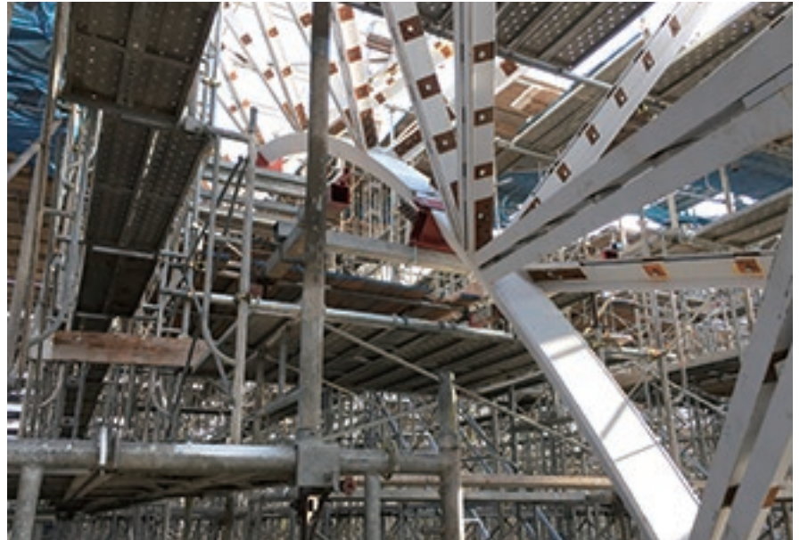
鉄骨建入れ時、本締め時の入念な精度管理を行う
