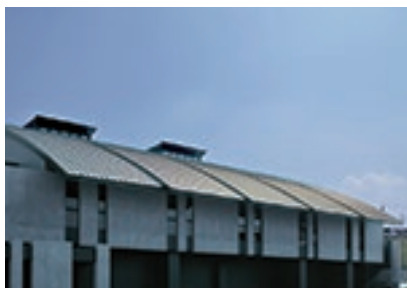
北面外観 5枚に分かれた屋根と屋根頂部を跳ね上げた「エコフェザー」
