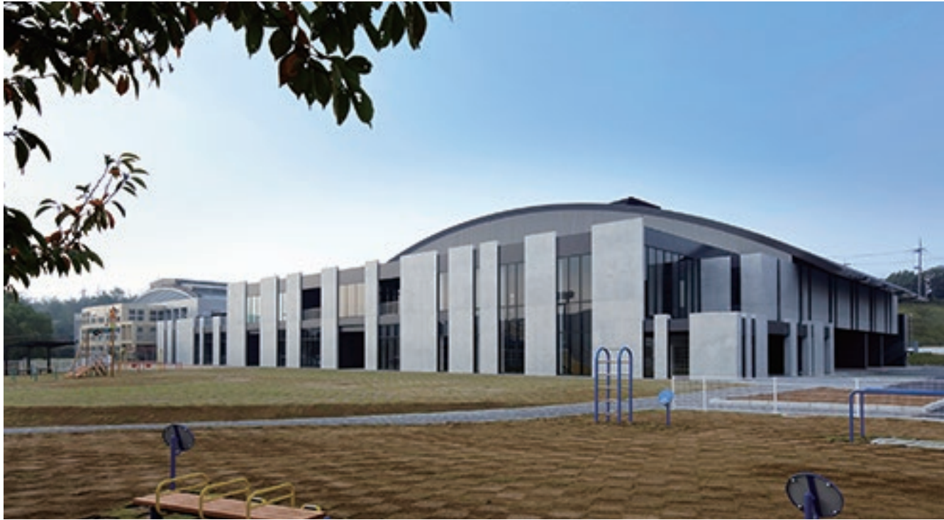
体育館東側外観
