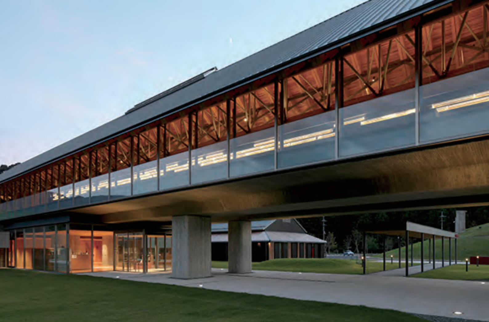
北側からの外観 RC造のピロティの上に展示室と切妻屋根が載る
