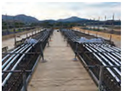
梁の型枠 打設後、PC鋼線で緊張させる
