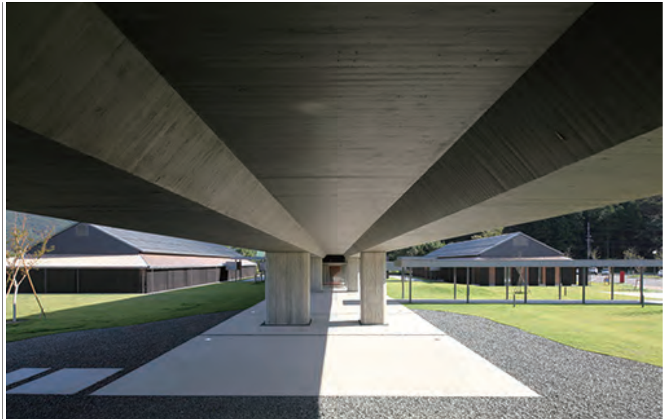
1階ピロティ 杉板型枠によるコンクリート打ち放し
