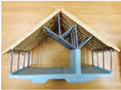
④登り梁以外の部材を鉄骨造とした採用案
