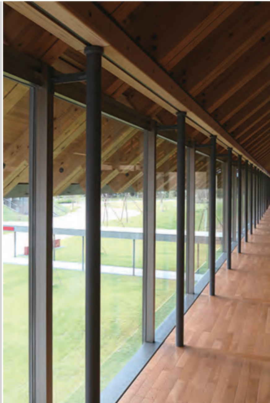
2階展示室の窓面 細径の鋼管とガラスのカーテンウォールが開放的な空間をつくる
