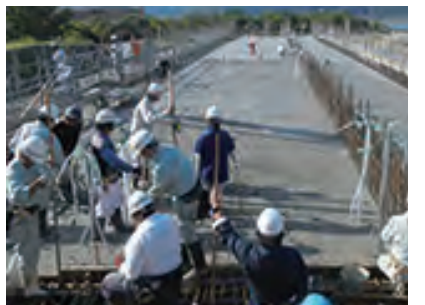
スラブ打設 竹竿でコンクリートを動かす
