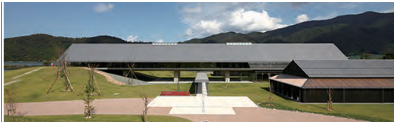
建物全景 1階はエントランスとピロティ、2階には展示室とカフェがある
