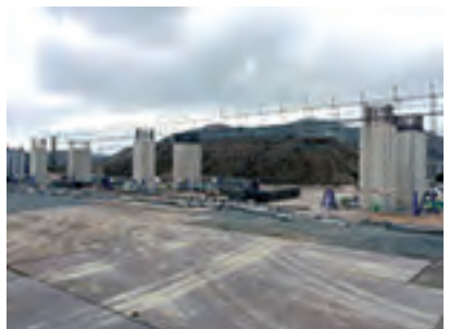
柱を打設後、梁の型枠を組む
