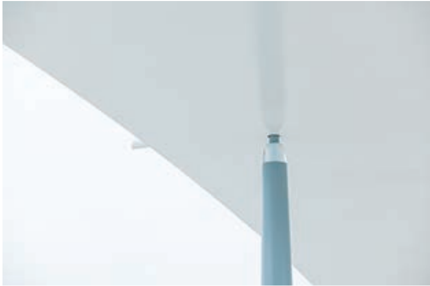
支柱頂部 照明カバーには光学ガラスを採用
