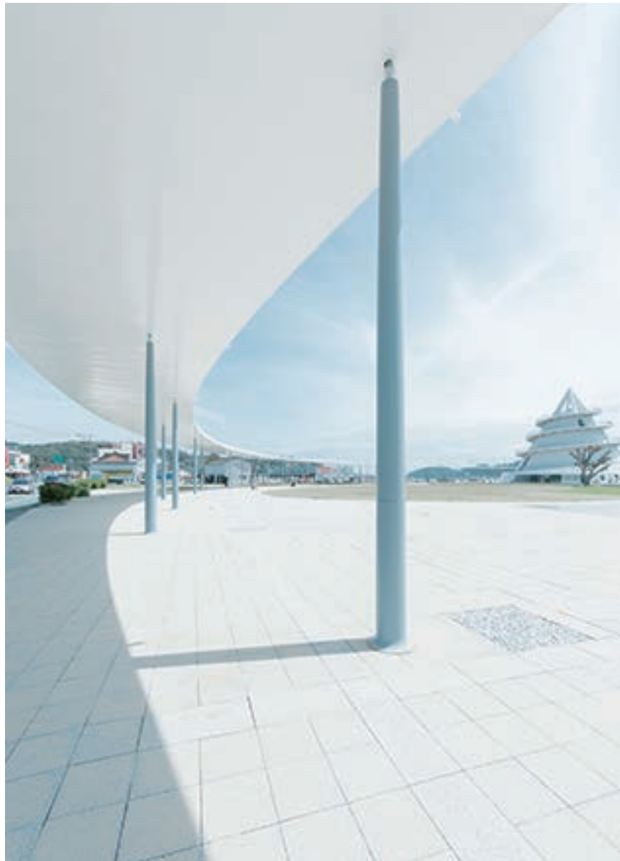
緩やかにカーブのかかった屋根が人々をフェリー乗り場まで誘導する
