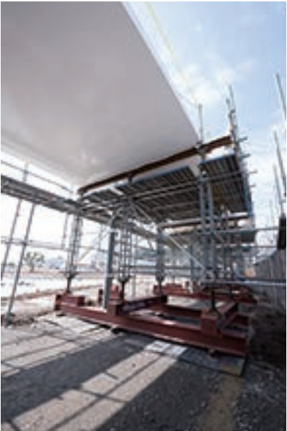
ベントを建てて屋根を支えながら施工
