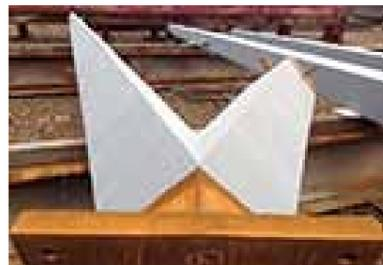
V字柱の板継溶接、シーム溶接はグラインダーで仕上げ、彫刻のように。また、耐火塗装は厚塗りし、紙ヤスリで磨くことで平滑に
