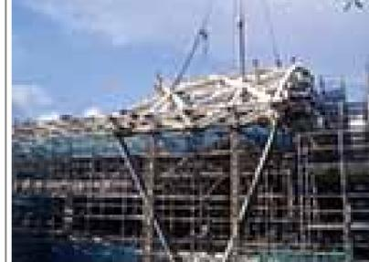
地組みしたユニットを吊り上げて溶接
