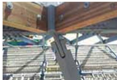
先端まで菱形に見えるようにガセットプレートの形状を工夫
