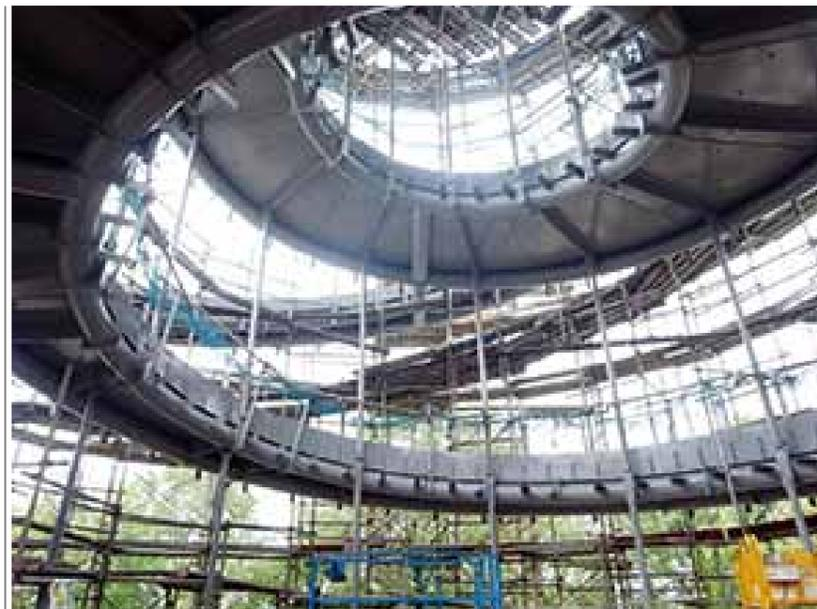
内側の螺旋を直径100mm、鉄骨無垢の鉛直間柱が支える
