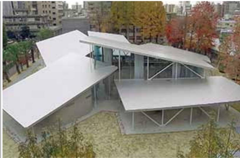
北側外観 中央の屋根 (A棟)と手前右の屋根 (G棟)の欄間部分にブレースを配置
