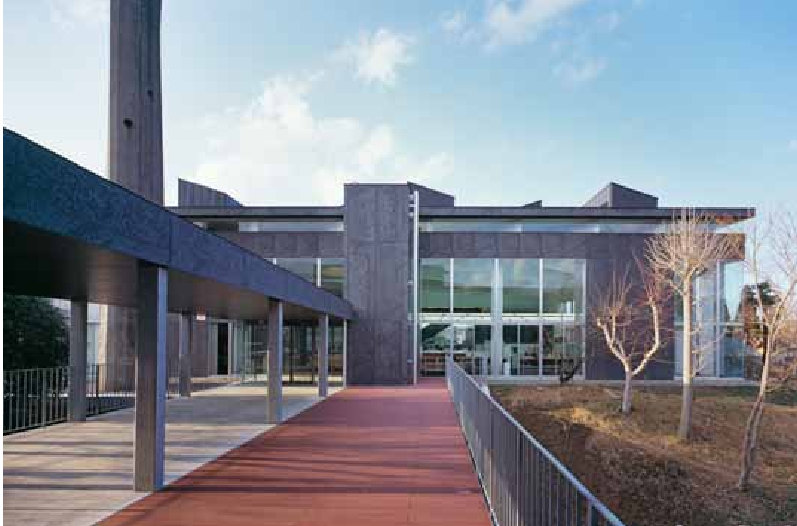
既存棟から増築棟を見る
