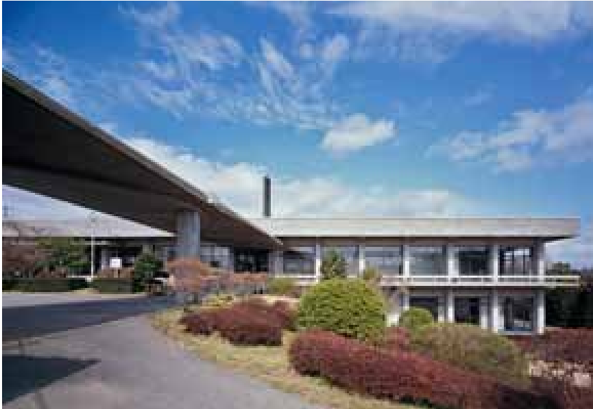
既存棟外観 右に地下部分が見える
