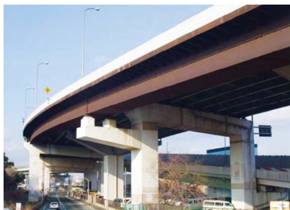
メンテナンスミニマムに貢献する耐候性鋼橋梁
