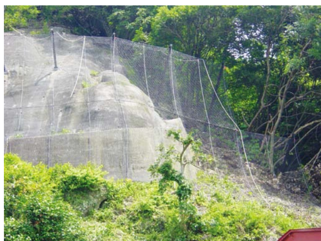
ポケット式落石防護網
