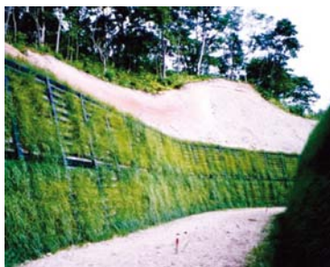
土留工（表面緑化）
