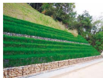
道路擁壁（緑化）
