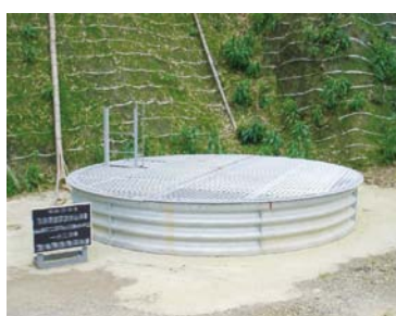
ライナープレート集水井外観
