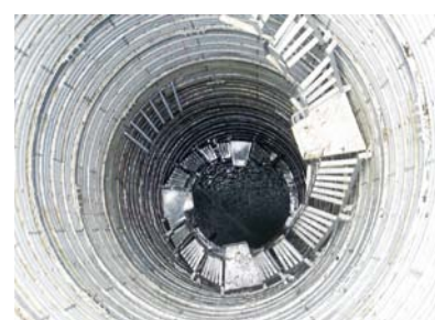
ライナープレート集水井内部
