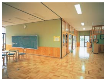
可動間仕切りを使用した教室
