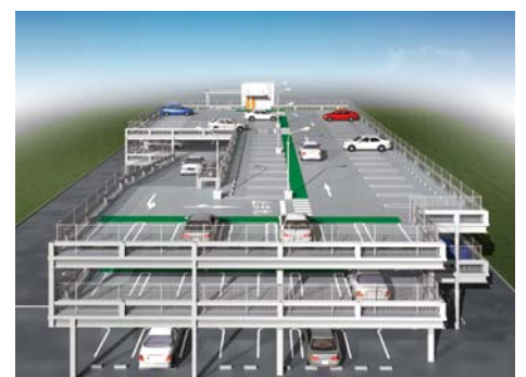
津波避難兼用駐車場の一例
