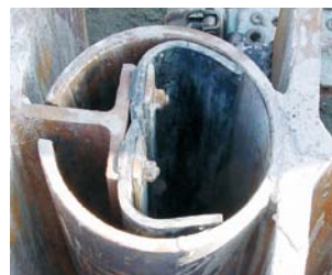
モルタル充填前
