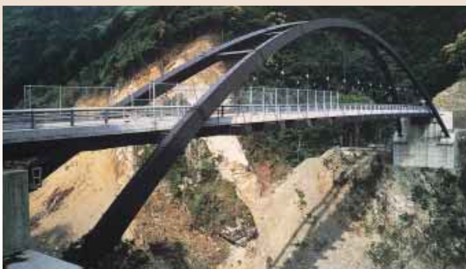
<写真説明> 表紙：乙姫大橋 岐阜県 1995年竣工 裏表紙：椿橋 熊本県 1992年竣工
