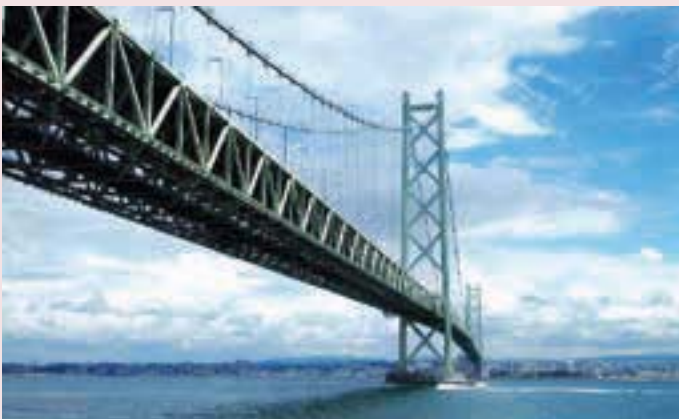
明石海峡大橋
