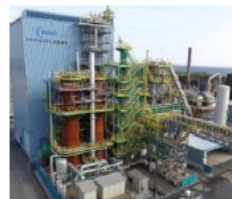
12m³小規模試験高炉（水素還元） （出典）経産省「グリーン鉄研究会」
