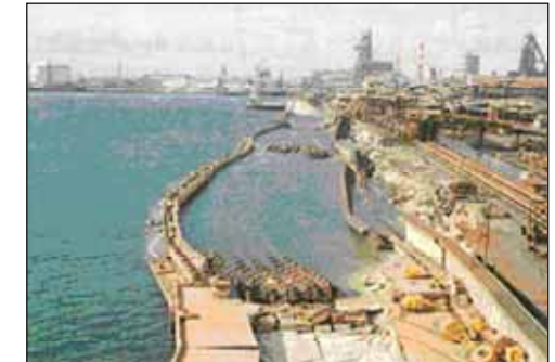
1995年阪神大震災 岸壁の被災 (神戸製鋼技報/Vol.46)
