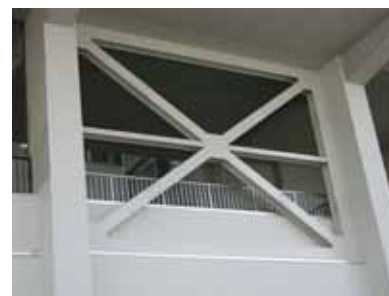
耐震補強の一例
