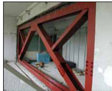
耐震補強の一例
