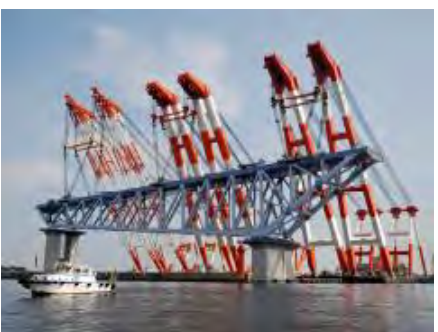
施工時の安全確保事例
