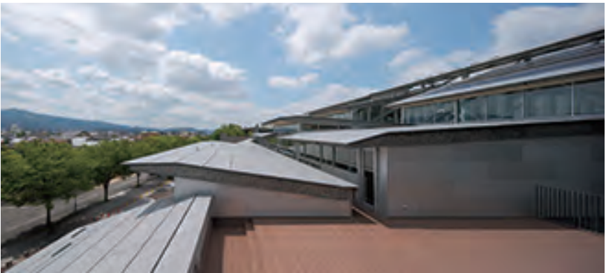
屋根を北側から見る。屋根の角度や先端の勾配はひとつずつ異なる
