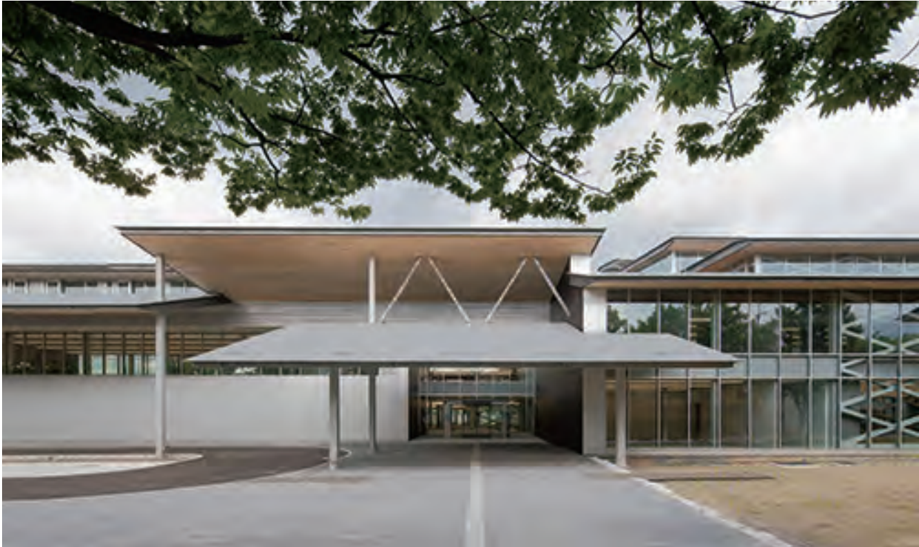
東側の資料館のエントランスを見る。軒を支える柱は建物の他の柱と同様すべて250mm角。屋根の天井部分には仕上げ材としてスギを使用
