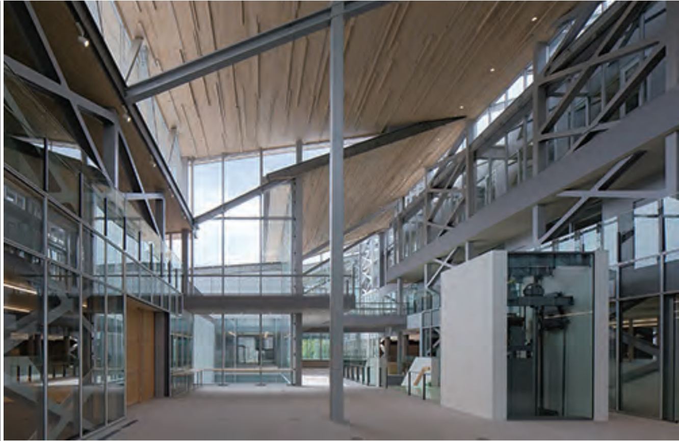
2階の吹き抜けにある一般閲覧スペース。屋根を構成する斜め梁と格子状の耐震ラチスブレースが見える
