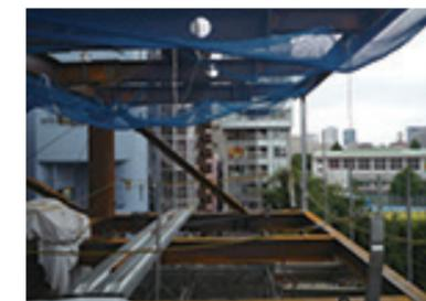
6階床建方 跳ね出し部の鉄骨フレーム
