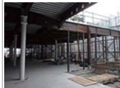
極厚シームレス鋼管を施工
