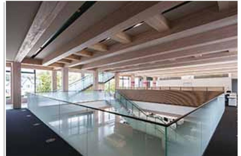
長スパン方向の小梁を大梁と同サイズにすることで、木質化された梁が1.6mピッチで一方向に現れる
