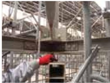
ジャッキダウン時の鉄骨梁の挙動測定
