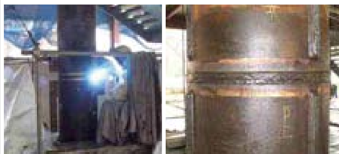
鋼管柱継手の現場溶接状況
