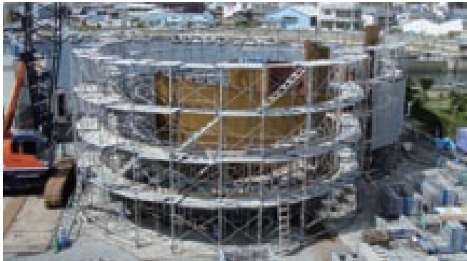
外周に支保工を設置
