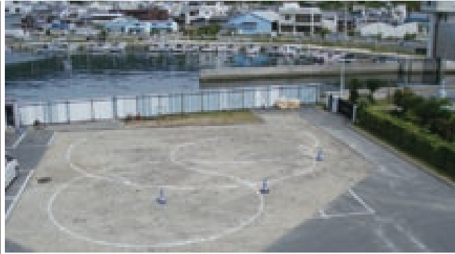
円弧壁のジオメトリーを地面に墨出し
