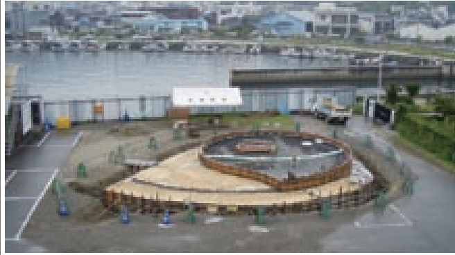
マットスラブ打設
