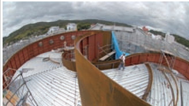
屋上デッキスラブ
