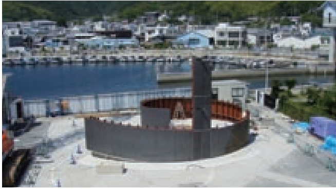
1段目の曲面壁のパネルを設置
